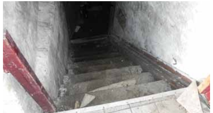
Abstieg in den zur Gänze verrauchten Keller mit Lokalisierung einer wirklichen Brandstelle in einem Fass (Fotos ohne Rauch dargestellt)
